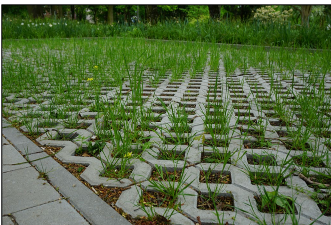
Figur 7.5 Exempel på utformning av genomsläppliga ytor. Foto: NIRAS
