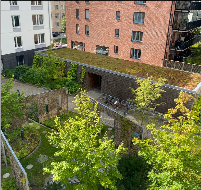
Figur 7.4 Exempelbild grönt tak. Komplementbyggnad på innergård. Foto: NIRAS
