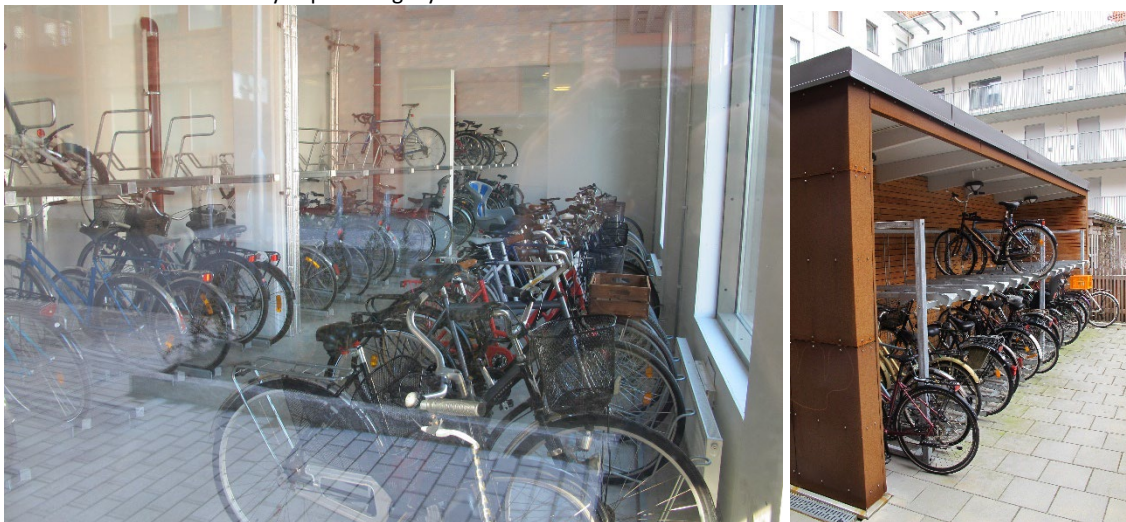
Tv: invändigt cykelförråd i bostadshus, uppglasad fasad mot gatuplan. Th: Cykelparkering på gård i två plan med regnskydd.
