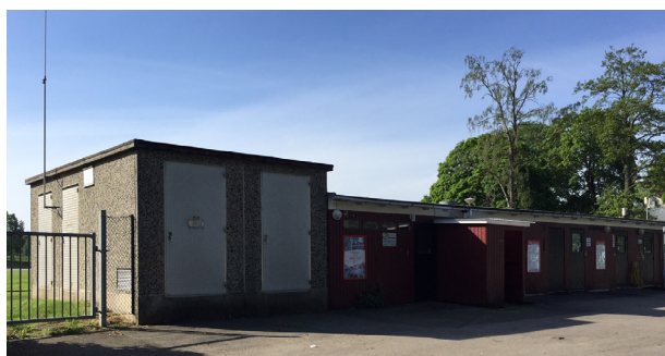
Nätstation vid entrén till Skara Arena
