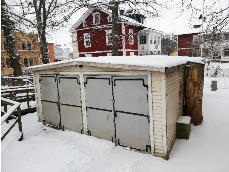
Figur 30. Förrådet sett från skolgården.
