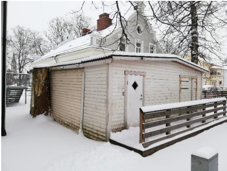
Figur 21. Förrådet sett från fastighetsgräns mot Granen 3.
