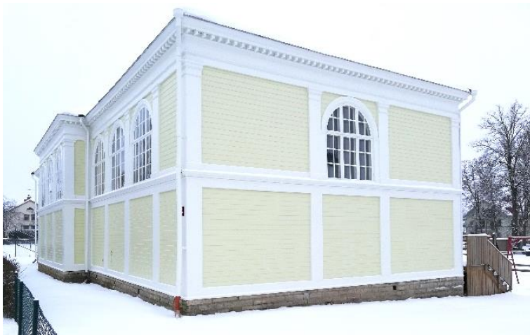
Figur 13. Annexet sett från Sturegatan.
