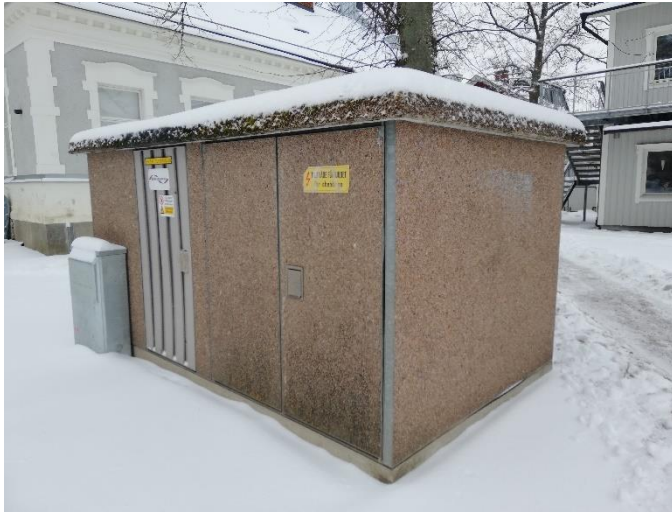
Figur 28. Transformatorstationen sedd från skolgården.
