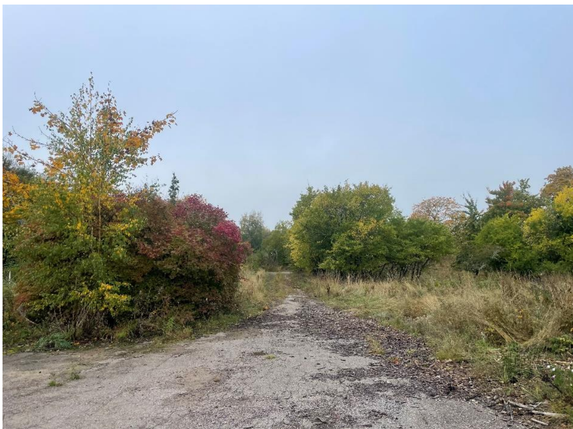
Figur 13. Rester från den äldre, asfalterade vägen
