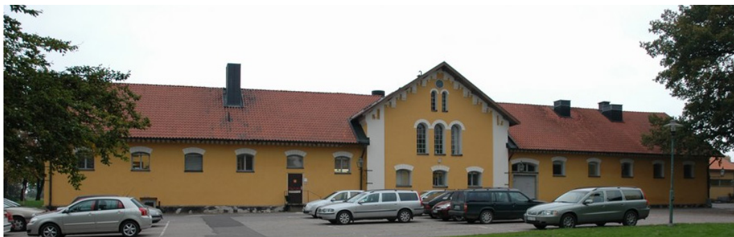
SKYTTEN 2, klinikbyggnad, fd ladugården.
