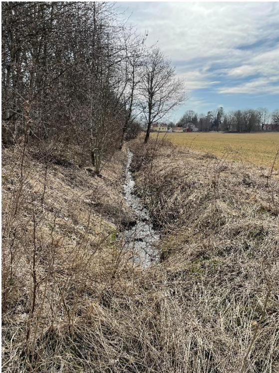
Figur 9. Diket väst om banvallen, ansvarar för avvattning av åkermark samt området norr om riksväg 49.
