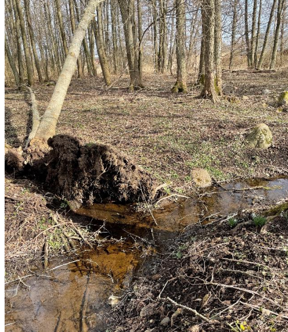
Figur 4. Skogsområdet öster om banvallen med ett vattendrag som rinner från banvallen mot en trumma under Axevallavägen.
